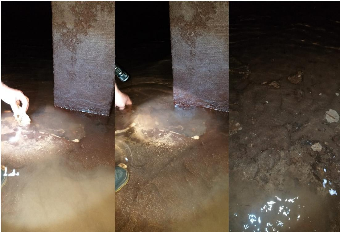
**Figura 3.4:** Descolamento revestimento de fundo
