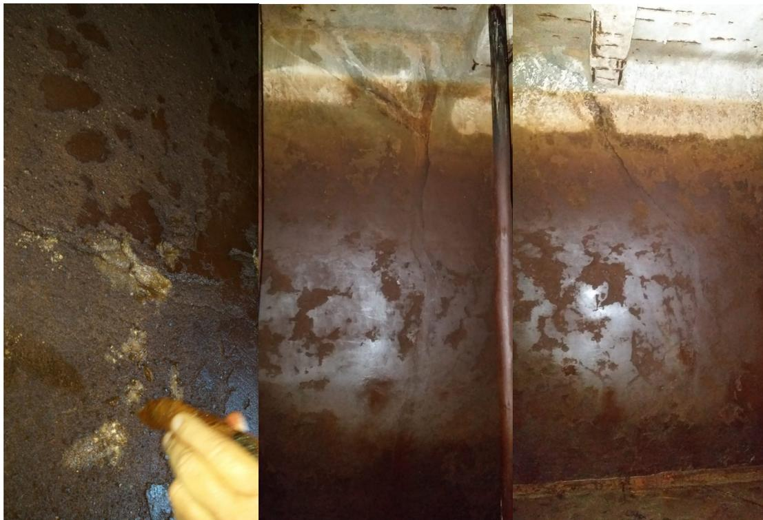
**Figura 3.2:** Trincas e rachaduras internas
