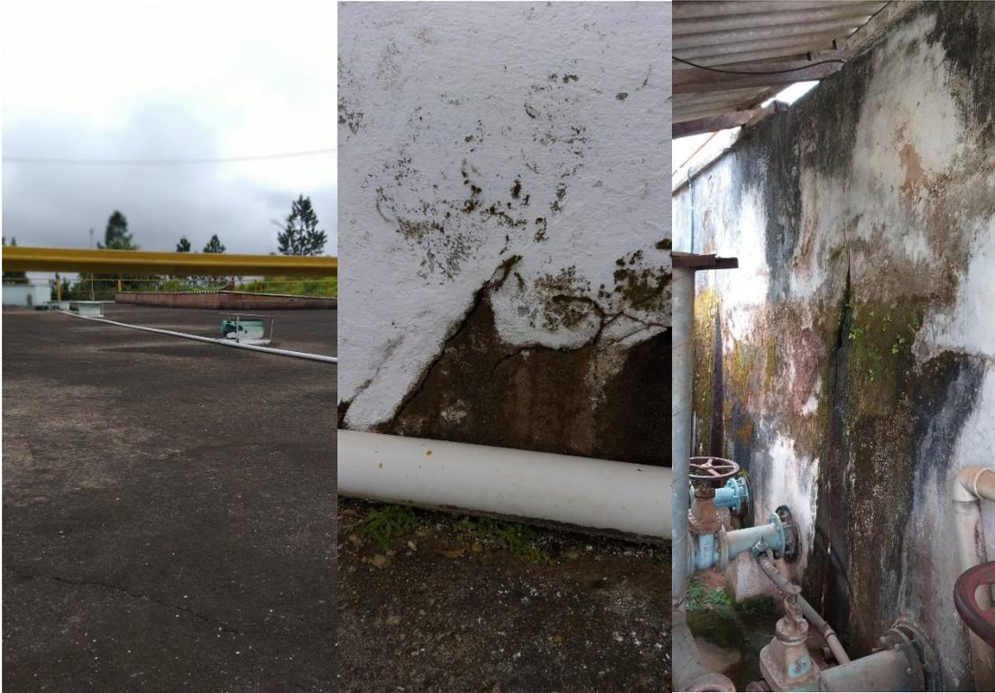
**Figura 3.1:** trincas e rachaduras externas, refletivas na parte interna do reservatório de concreto:
