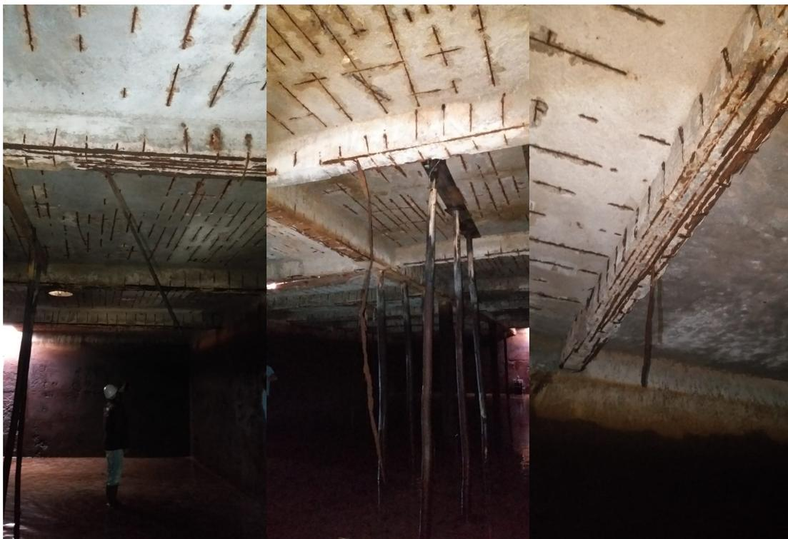
**Figura 3.3:** Exposição das ferragens da laje e viga devido à perda de cobertura da armadura
